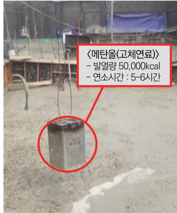
겨울철 콘크리트 양생 부실로 인한 대표적 사고 (2022.01.13 OO산업개발)
