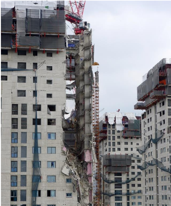
겨울철 콘크리트 양생 부실로 인한 대표적 사고 (2022.01.13 OO산업개발)
