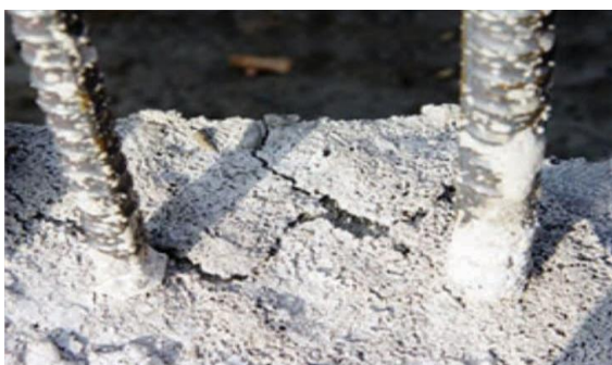
한중 콘크리트 타설 후 초기 동해 피해 모습
